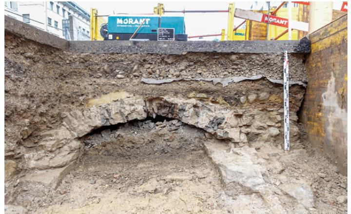
St. Gallen, Marktplatz/Bohl. Grosser Entwässerungskanal mit gemauerten Wänden und Gewölbe nur wenig unter der Oberfläche des Bohls. Foto KASG.
