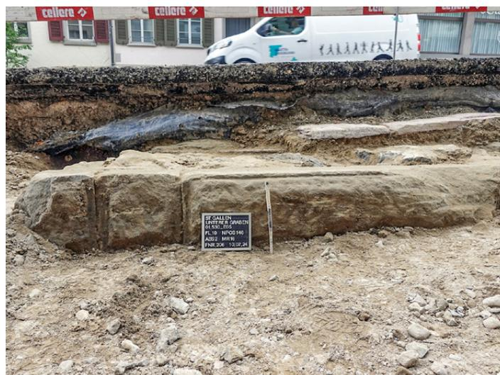
St. Gallen, Unterer Graben. Ansicht der Stützmauer des Bahneinschnitts von 1856 mit bossierten Sandsteinquadern. Foto KASG.
