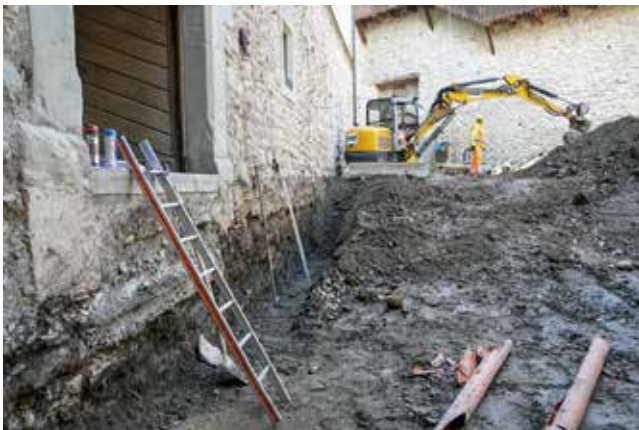
Rapperswil-Jona, Schloss. Begleitung der Sanierungsarbeiten im Innenhof, Blick auf Nordmauer des Palas. Foto KASG.
