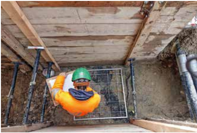
St. Gallen, Marktplatz. Beengtes Arbeiten in den gespriessten Leitungsräben. Foto KASG.
