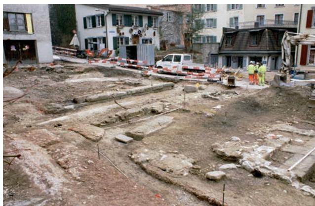
St. Gallen, Pic-o-Pello-Platz. Rechts Mauern des Kernbaus des 11.–14., ganz rechts des 18. Jahrhunderts. Die Häuserzeilen stehen am Ort der Stadtmauer und des Bollwerks. Bildmitte: Stützmauer für den ältesten Kanal, davor Aussparung für einen jüngeren Kanal. Darin die moderne Kanalisation, welche durch die alte Felsrinne (ganz links) zieht. Foto KASG.
