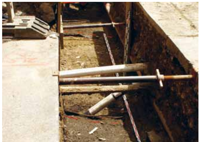
St. Gallen, Latrine an der Webergasse. Die Wände waren mit einem korbartigen Geflecht ausgekleidet. Die hellere Einfüllung hebt sich deutlich von den umliegenden dunklen Kulturschichten ab.
