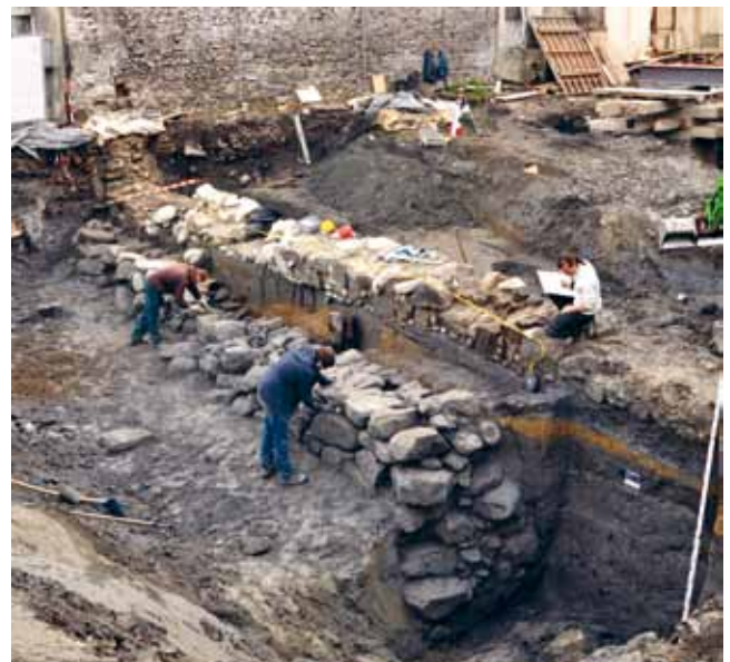
Rheineck, Kronenareal. Blick auf Uferbefestigung (vorne) und Stadtmauer (hinten) von Nordwesten. Foto KA SG.
