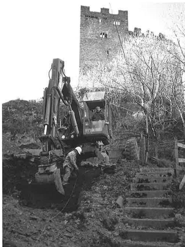
Abb. 3. Wartau, Gretschins. Bau einer Kanalisationsleitung unterhalb der Burg Wartau. Foto KA SG.
