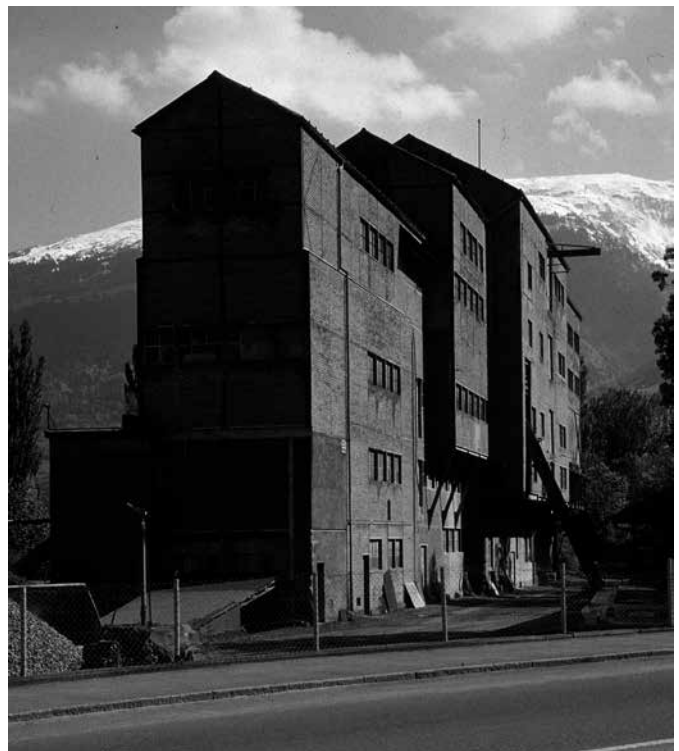
Das Schotterwerk Sargans gehört zu den historisch bedeutsamen Industriebauten der Schweiz. (Bilder: zVg Kantonale Denkmalpflege)
