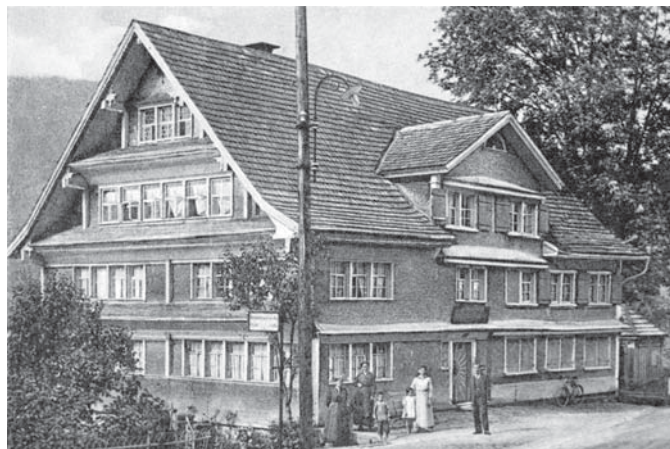
Alter Hirschen, Krummenau (Bild: zVg Kantonale Denkmalpflege)
