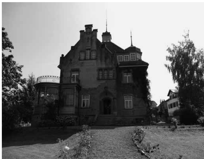
Villa Roseck, Rosenbergstrasse 5, Kirchberg; Innenrenovation. (Bild: zVg Kantonale Denkmalpflege)
