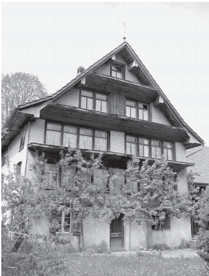
Das Haus Buomberg in Kirchberg. (Bild: zVg Kantonale Denkmalpflege)
