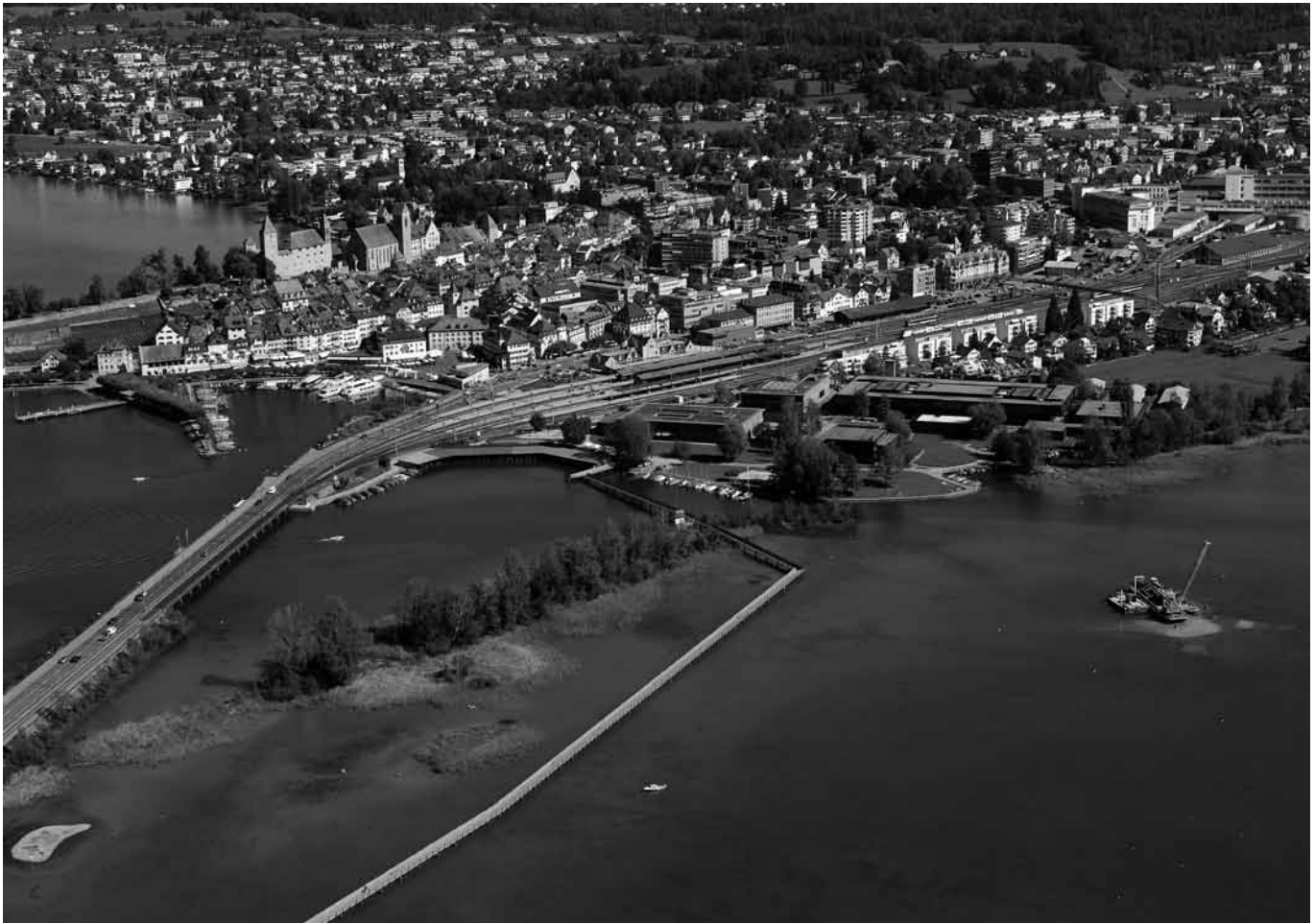
Überblick über die Schutzmassnahmen 2011 an der Fundstelle Rapperswil-Jona, Technikum. Die genaue Kenntnis von Fundstellen erlaubt adäquate Sicherungs- und Schutzmassnahmen. (Bild: zVg Archäologie Kanton St.Gallen)
