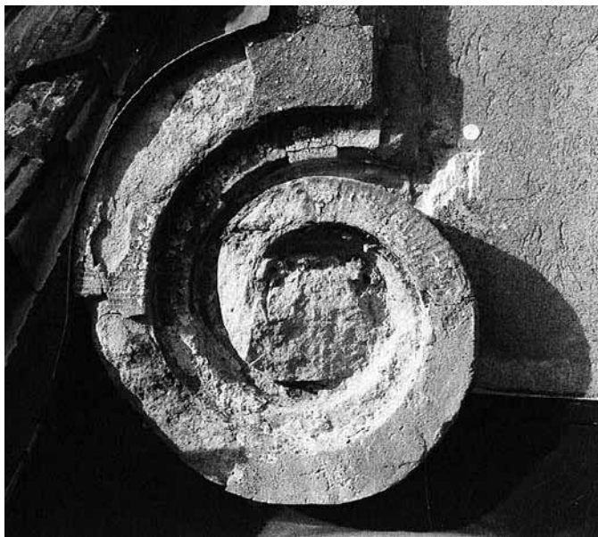
Element an der Fassade des Wiler Rathaus. (Bild: Kantonale Denkmalpflege)
