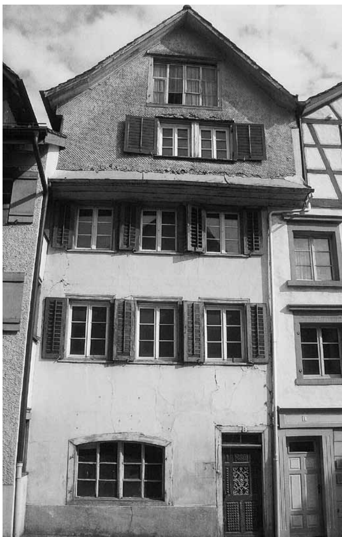
Haus an der Tonhallestrasse 3 in Wil. (Bild: Kantonale Denkmalpflege)
