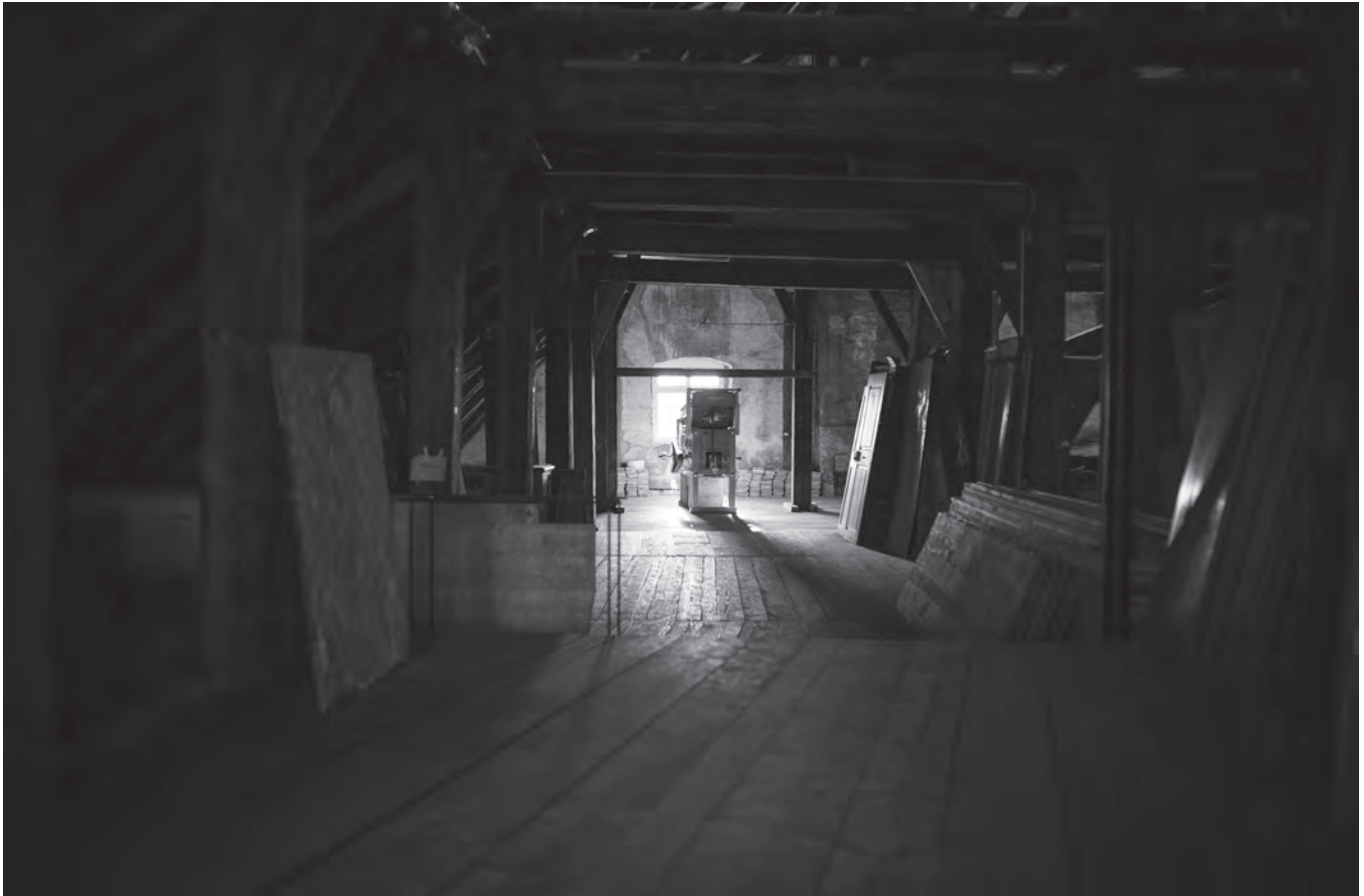
In der 3. Bauetappe soll auch der riesige Dachstock im Hof Wil erschlossen werden. Zuvor wird eine sorgfältige Nutzungsplanung durchgeführt. (Bild: zVg Stiftung Hof zu Wil)
