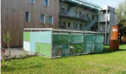
Veloparkplätze in Nebengebäuden sind besser zu erreichen und günstiger zu erstellen als in Untergeschossen
