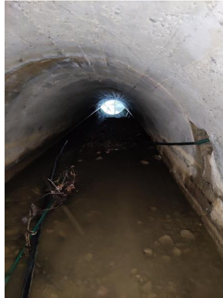
Abbildung 4: Auslaufbereich mit Kreisprofil
