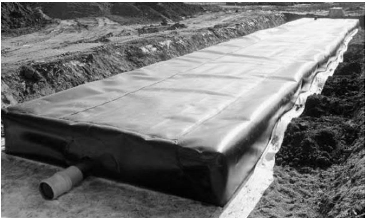
Abbildung 6: Bsp. Retentionsbecken Rehau
