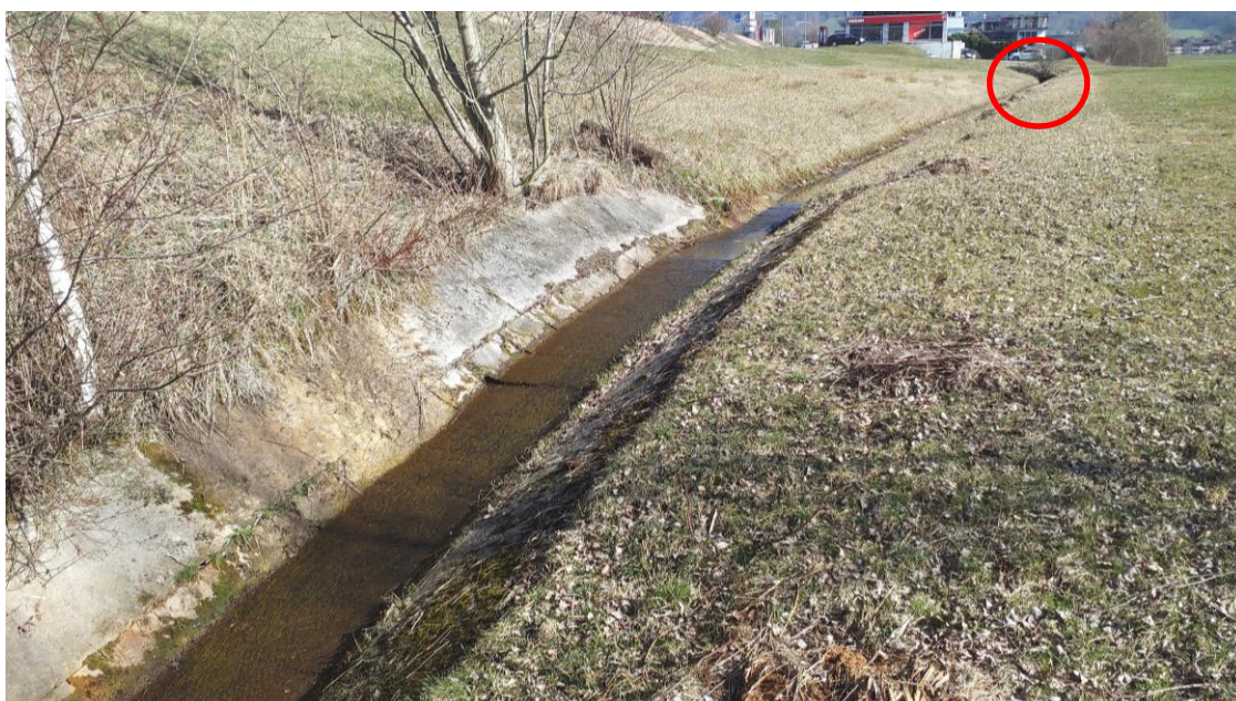
Abbildung 7: Unterer Abschnitt des Witöfeligrabe. Blick gegen die Fliessrichtung. Im Hintergrund der Abbildung ist der Einlauf des Strassenabwassers erkennbar (roter Kreis).
