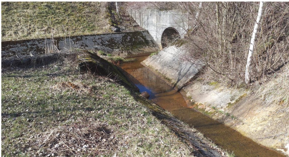
Abbildung 6: Unterer Abschnitt des Witöfeligrabe mit der Einleitung in den Linth Nebenkanal. Blick in Fliessrichtung. Erkennbar sind die hart verbauten Uferböschungen und die Betonsohle.
