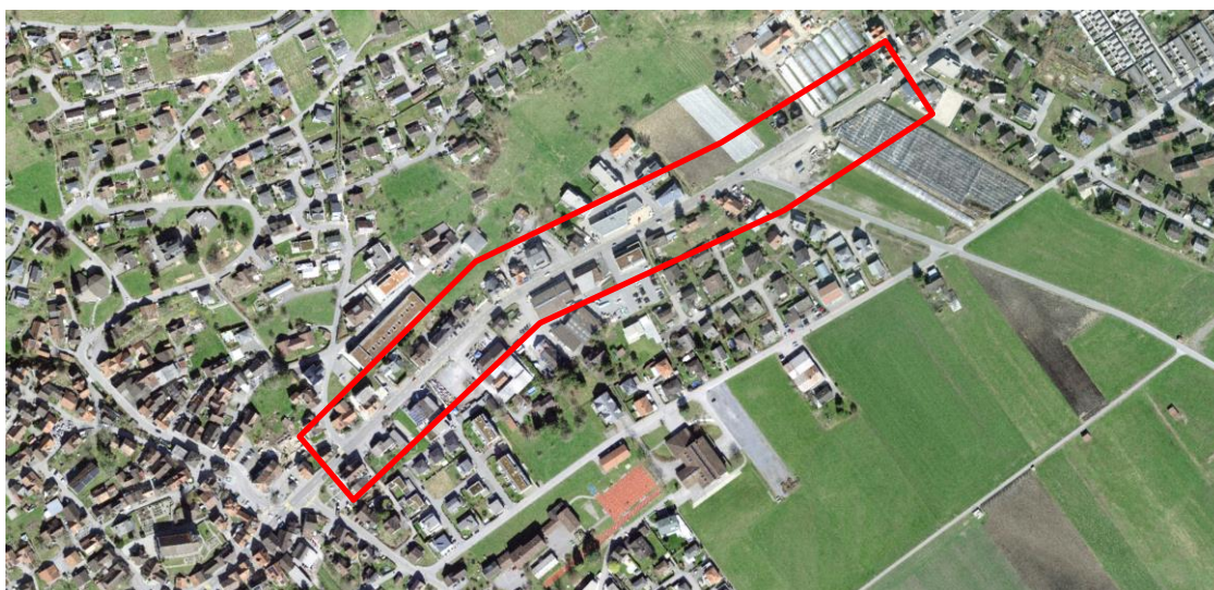
Abbildung 1: Orthofoto mit Projektperimeter ( www.geoportal.ch )
