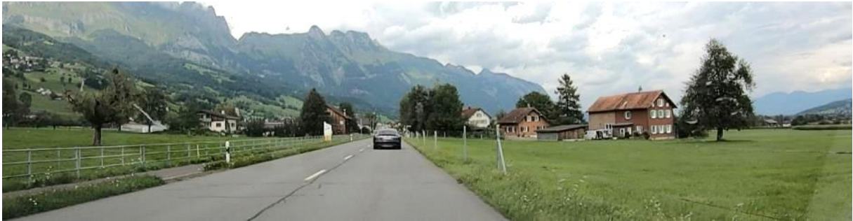
Abbildung 10: Einfahrt Perimeter (Ri. Gams)
