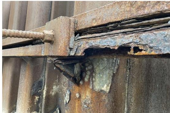
Abb. 2: Korrosion an Longarine und Spundwandprofilen
