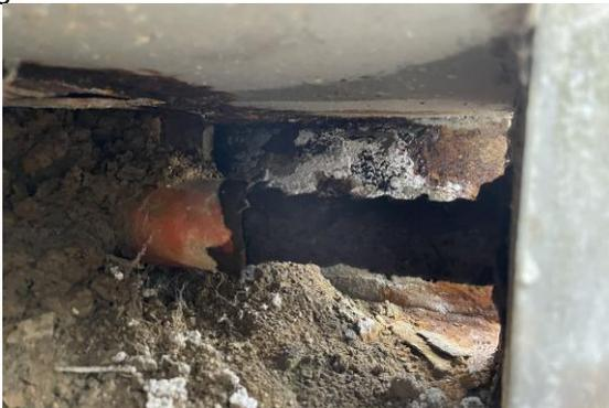
Abb. 1: Ungeschützter Anker hinter Longarine
