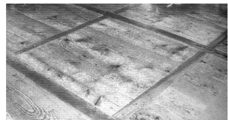
Bretterboden mit Hartholzeinlagen.
