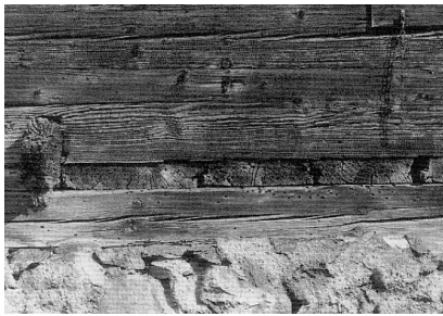
In der Fassade sichtbare Bohlen.
