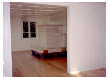
Der Wandschrank wurde um ein Element verkleinert für den Durchgang vom Wohn- zum Esszimmer.
