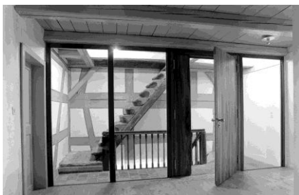
Verglaster Raumabschluss zum Treppenhaus mit Blocktreppe.
