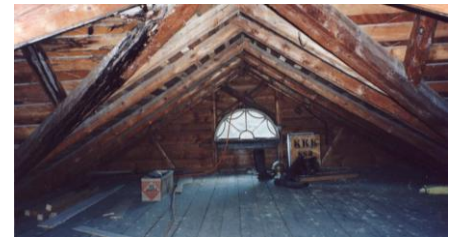
Dachstock vor dem Umbau
