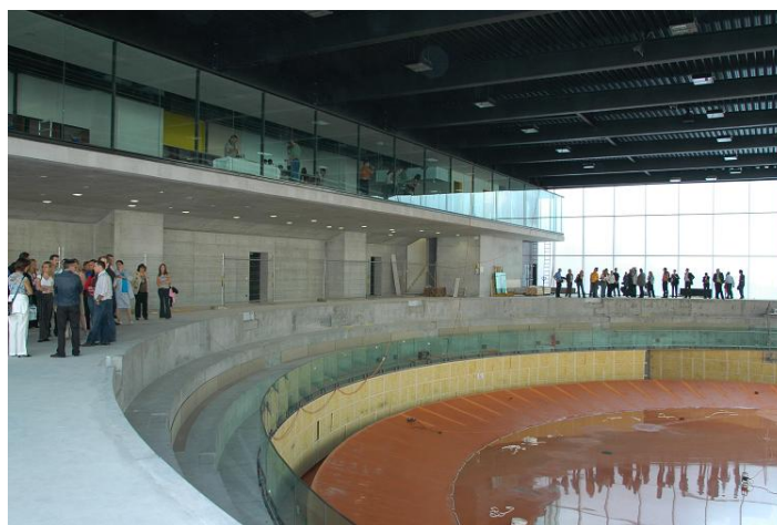
Athletik Zentrum St.Gallen in der Bauphase
