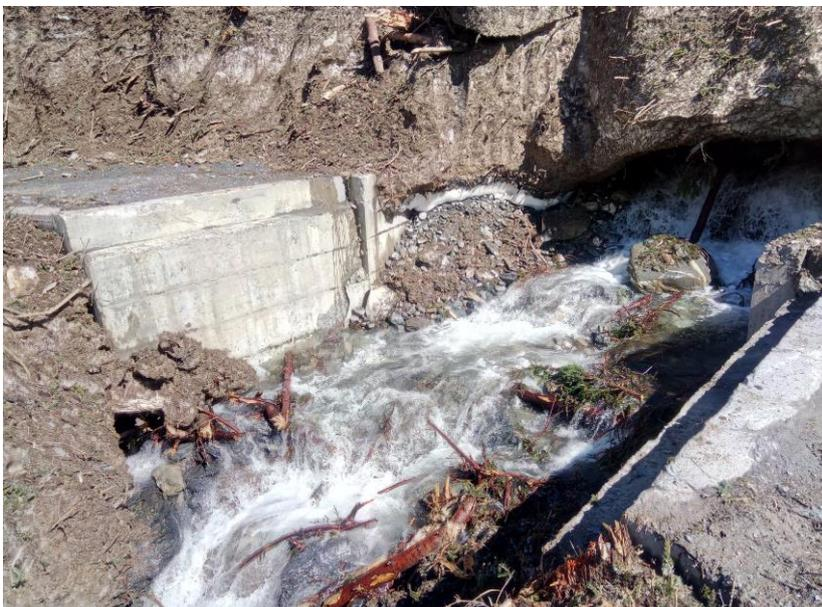
Lawinenschäden an einer Strassenbrücke im Calfeisental.
