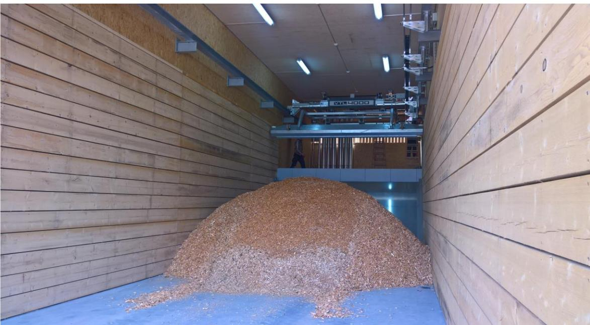
Inbetriebnahme der Wärmezentrale und Lieferung der ersten Hackschnitzel, bereit für die Förderung durch den Toploader.
