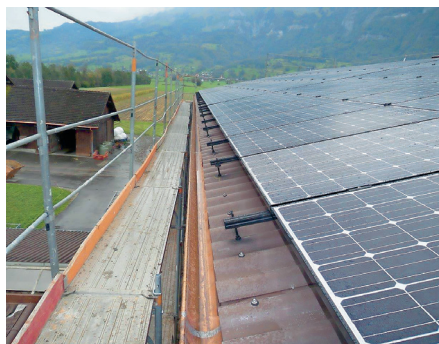
Montage der Photovoltaikanlage auf der Scheune des Gutsbetriebes LZSG in Salez
