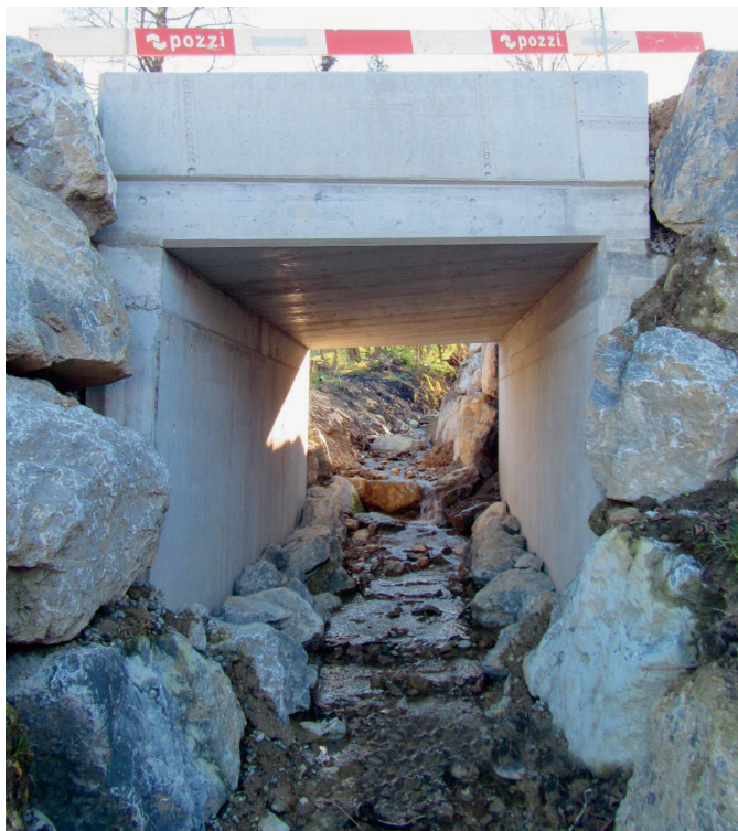
Erschliessung Büchel – Näppis – Näckli Wattwil: neue Betonplattenbrücke
