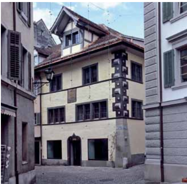
Das Haus zum Schwarzen oder Goldenen Adler in Rapperswil erhielt für die sorgfältige Restaurierung 2010 den Schweizer Denkmalpreis (Foto: kant. Dpfl).
