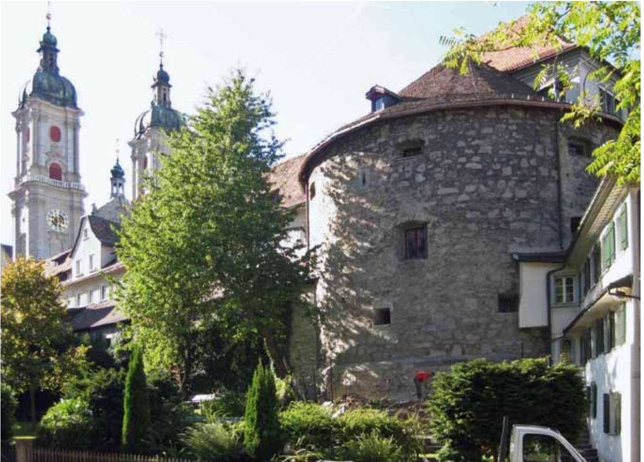
Der Runde Turm mit dem sorgfältig konservierten 500-jährigen Verputz (Foto: kant. Dpfl).
