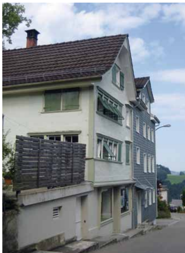
Lebendigkeit eines gestrichenen Holzschindelschirms neben einer zu Tode sanierten Eternitfassade in Mogelsberg (Foto: kant. Dpfl).
