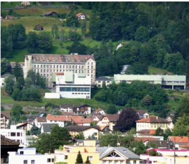
Zwei «Industrieschlösser», die ihre Dörfer architektonisch dominieren: Die 1866 erbaute Spinnerei Spoerry in Flums und die 1875 erbaute Spinnerei Stoffel in Mels. (Fotos: Kant. Denkmalpflege)
