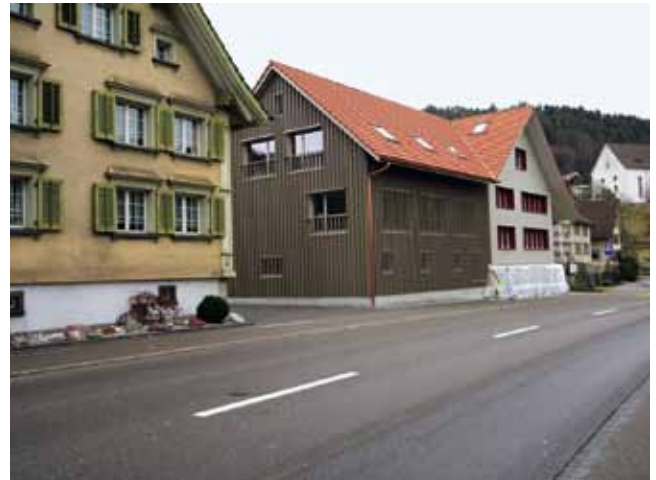
Der nicht geschützte Kreuzfirshof in der Balgacher Ortsbildschutzzone erhielt 2011 einen (wiederum hölzernen) Ersatzbau für die Stallscheune. Dank des Holzrasters vor den Fenstern erscheint die Strassenfassade des Neubaus schon aus kurzer Distanz als eine geschlossene Fläche. (Foto: Kant. Denkmalpflege)
