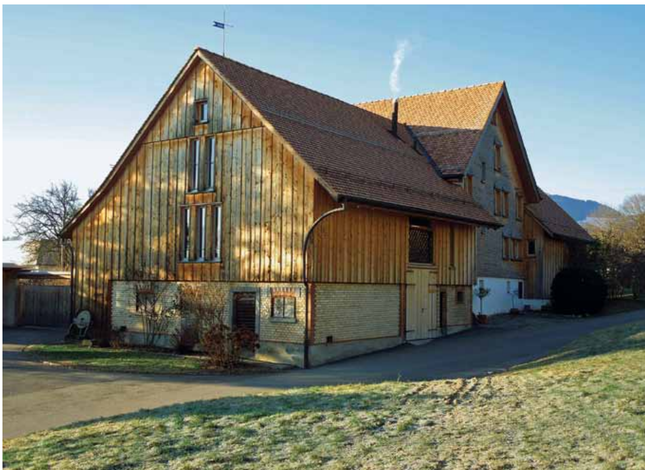
Berneck, Rüden. Renovation des Bauernhauses und Umnutzung der beiden Scheunen durch Architekt Werner Bänziger 2003. Im Sockelbereich ist das Sichtbacksteinmauerwerk mit den Stallfenstern beibehalten worden, im neuen Bretterschirm passen sich die Fenster der Struktur des Holzes an. (Foto: Kant. Denkmalpflege)
