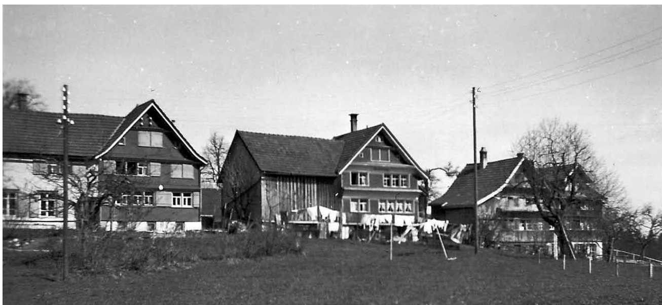
Neue Nutzungen für bestehende Gebäude sind keine Erfindung der Denkmalpflege. In Zeiten, als die Arbeit noch billig und die Rohmaterialien teuer waren, hatte die Weiterverwendung eine ganz andere Selbstverständlichkeit. In der Degersheimer Hofgruppe Berg stehen drei gleichartige Bauernhäuser nebeneinander, beim linken wurde in die Scheune 1901 ein Sticklokal eingebaut, beim rechten (hinter dem Baum) ist die Scheune schon vor 1875 zum Wohnhaus umgebaut worden. (Foto um 1950, Aktion Bauernhausforschung, Archiv kant. Denkmalpflege).
