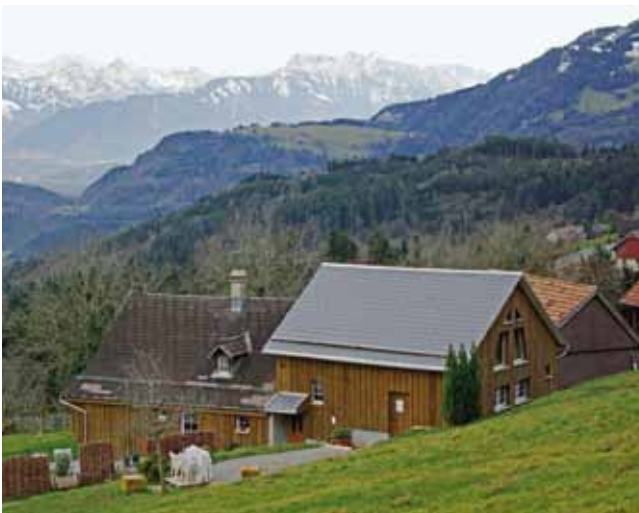
Altstätten, Gätziberg. Oben: Scheunenausbau an einem nicht geschützten ehemaligen Bauernhaus. Der Holzraster bricht die grosse Fensterfläche. – Unten: Einbau eines Praxiszimmers in die dem kleinen Wohnhaus angehängten Scheune, an der Giebelfront gegen den Hang stören auch grössere und aufgrund der Holzkonstruktion schräge Fensterformen nicht. (Foto: Kant. Denkmalpflege)
