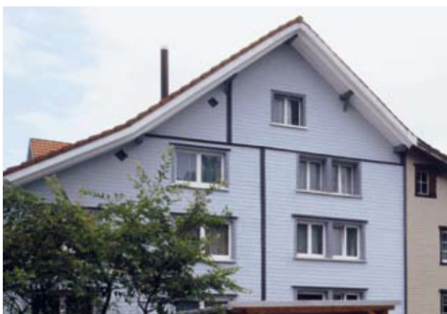
Alterswil und Bichwil. Durch die sehr tiefen Fensterleibungen verschwinden schon beim kleinsten Blickwinkel die Fenster und wirken wie Löcher; die Kopfhölzer des Dachvorsprungs versinken in der Isolierschicht (Fotos: kant. Denkmalpflege).
